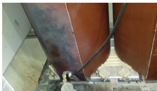
Detalle interior del transformador en el que probablemente se produjo el cortocircuito.
